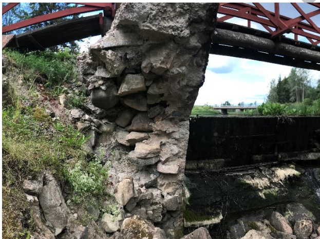
Figur 3.4. Den högra sidan av dammen är påverkad av erosion. Bild på nedströmssidan Bild: Norconsult, 2019.
