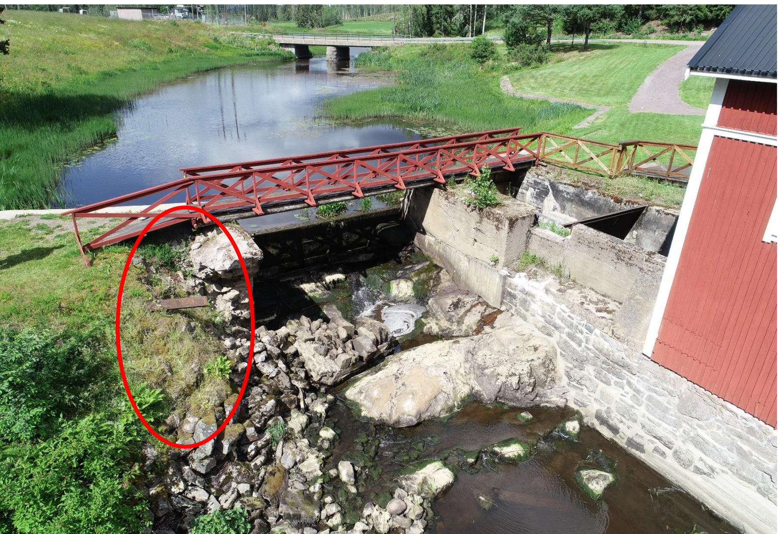
Figur 3.3. Den befintliga dammkonstruktionen sett från nedströmssidan. Den högra sidan är påverkad av erosion samt har ett läckage, område markerat med röd cirkel. Foto: Norconsult
