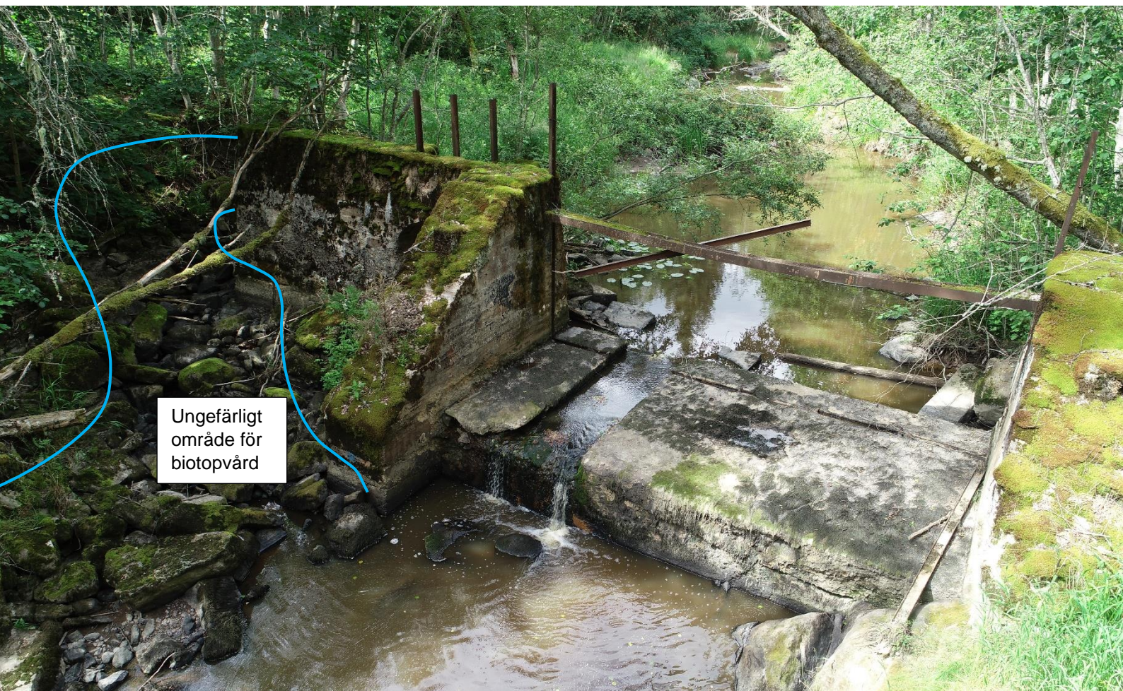
Figur 4.2. Nedströmssidan på dammen. Till vänster i bild finns den fåra som naturligt skapats då dammen delvis raserats. Bild: Norconsult. 2019.
