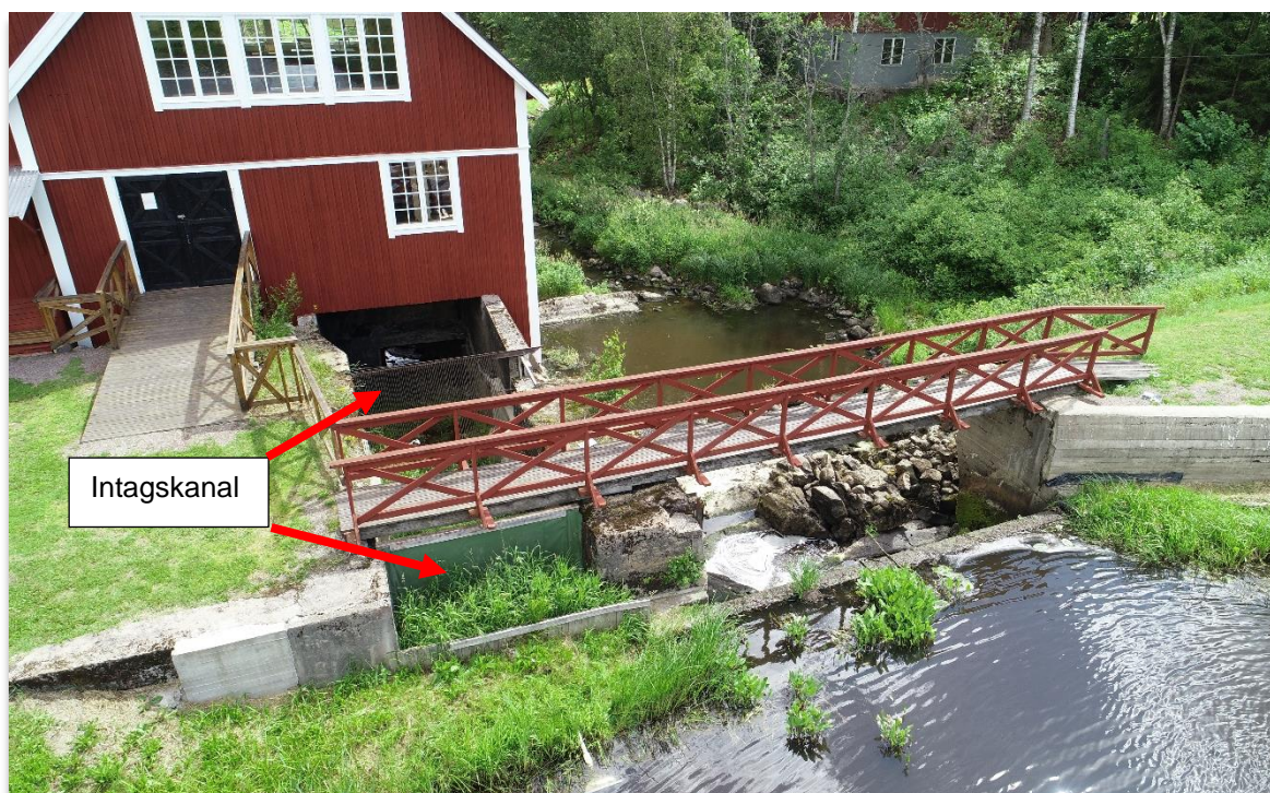
Figur 3.1. Kvarnen med tillhörande intagskanal vänster i bild. Spillutskovet höger i bild. Foto: Norconsult 2019.
