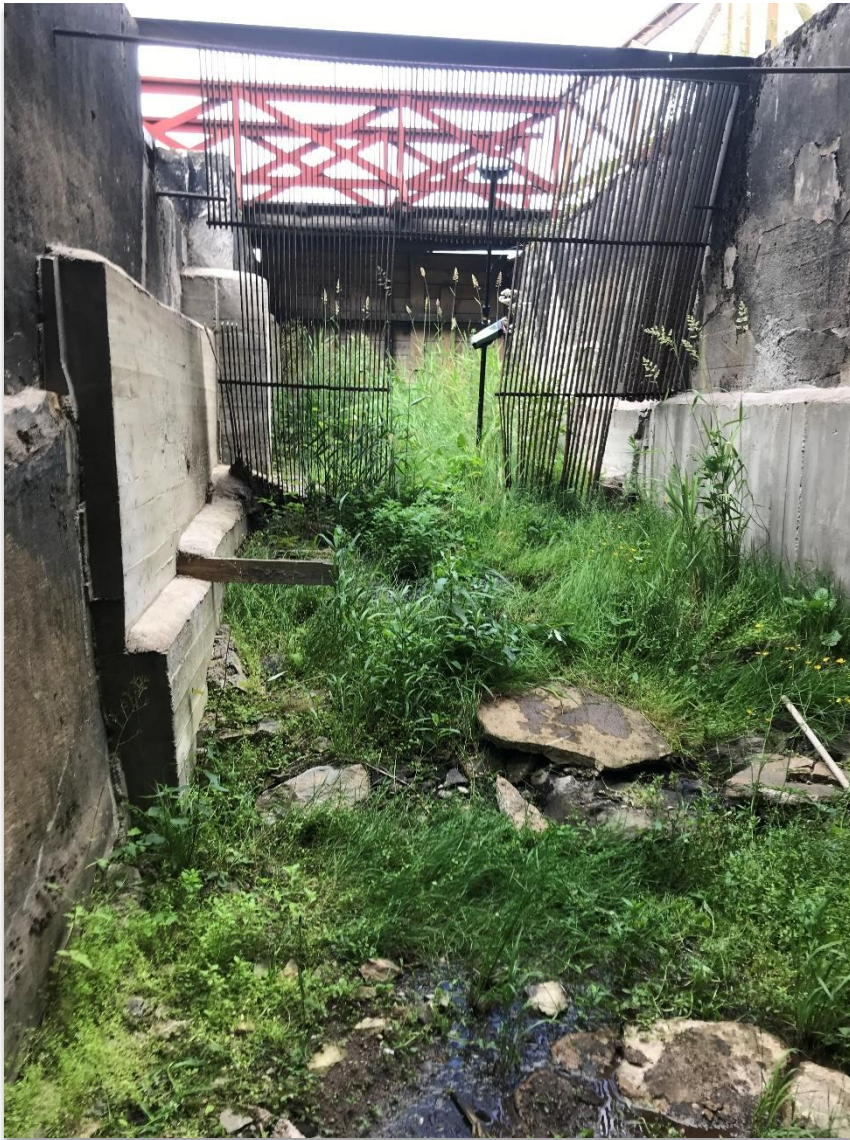
Figur 3.8. Foto från passagen in i kvarnbyggnaden upp mot det stängda intaget där den största delen av fallet tas ut. Foto: Norconsult 2019.
